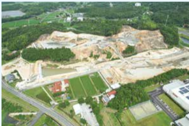
主な工事内容は、最初に山の木を伐採した後、造成土工として大型重機を使用して約20万㎡の土砂を掘削し、大型ダンプで運搬、盛土を行って敷地造成をする工事となります。
